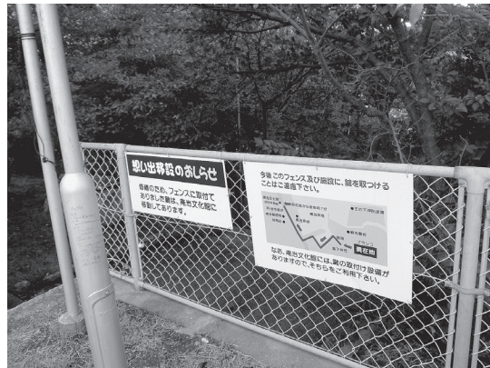
図8 皇子神社のフェンス改修と、「愛の鍵」の誘導 2008年8月27日・天野撮影
